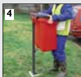
4 Plaats de afvalbak op de paal. Uitvoering en overzichtelijke montage-instructies zijn bijgeleverd.
