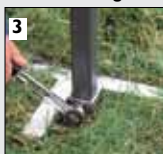
3 Steek vervolgens de paal in en schroef deze vast aan de verankeringsplaat.
