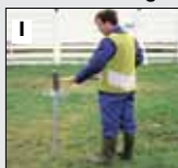
1 Het anker wordt in de grond geslagen d.m.v. een hamer.
